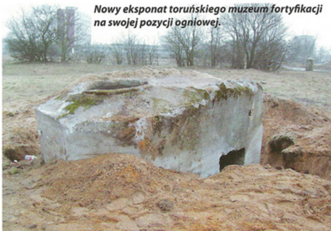
Osadzanie Ringstand'a w przygotowanym dla niego wykopie.
